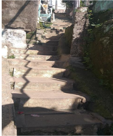
Figura 6 – Fotografia de trecho da escadaria no território do Monte Serrat
