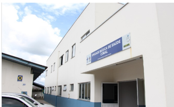
Figura 8 – Foto comparativa de partes das fachadas da UBS Coral antiga, à esquerda, e da nova estrutura, à direita.
